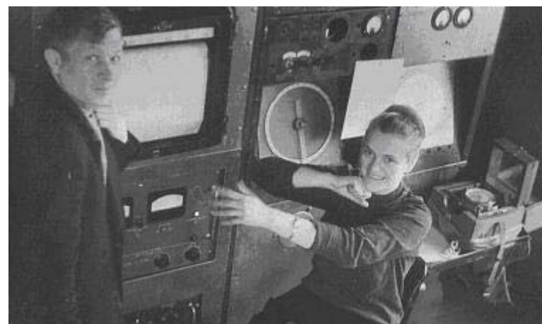
Рис. 2. Радиоаппаратура для регистрации радиоизлучения Солнца на частоте 208 МГц (1960-е гг.)
